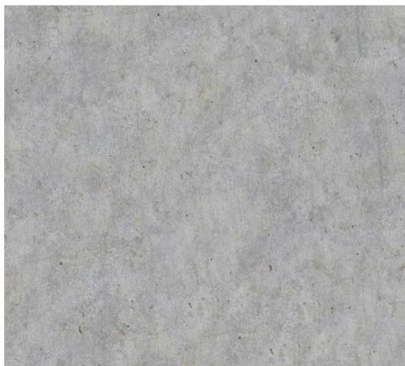
Figura 7 - Piso em Concreto Desempenado
